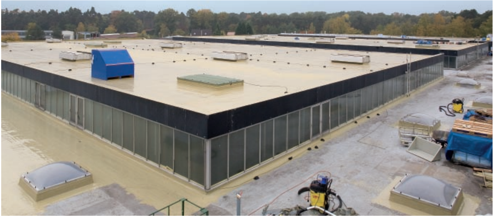
Insgesamt 12.000 qm Flachdachfläche auf verschiedenen Gebäuden werden bei Staehle Blechverpackungen mit KEMPEROL® abgedichtet.
