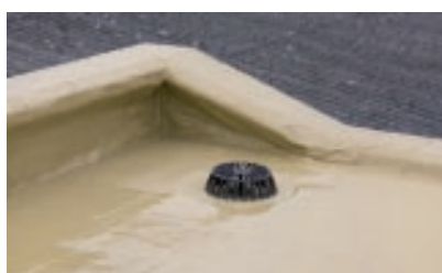
Die Attika wurde in ebenfalls abgedichtet und nicht neu verblecht.
