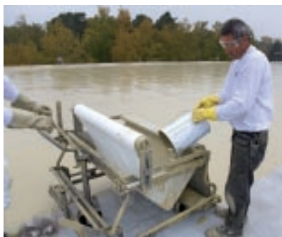
Das auf der Rolle in den KEMPERATOR eingespannte Vlies...
