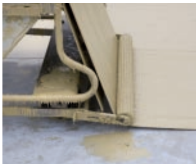
... wird beim Durchlauf in der Maschine mit KEMPEROL® vollflächig durchtränkt, durch ein Walzensystem geführt und faltenfrei auf der Fläche aufgebracht.
