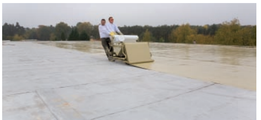
Speziell auf größeren Flächen erhöht sich mit dem ‚KEMPERATOR‘ die Verlegegeschwindigkeit um ein Vielfaches.
