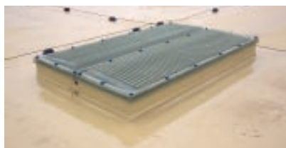
Alle Aufbauten wurden fugenlos in die Flächenabdichtung eingebunden.
