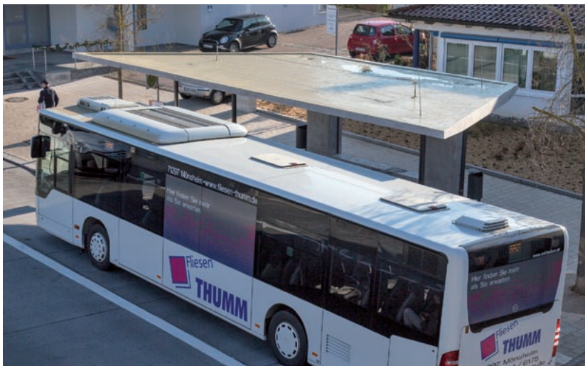
Die Dächer wurden mit einer rissüberbrückenden KEMPEROL® Abdichtung versehen.
