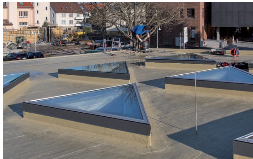
Abdichtung im Detail: Neun Lichtelemente durchbrechen die Dachfläche.
